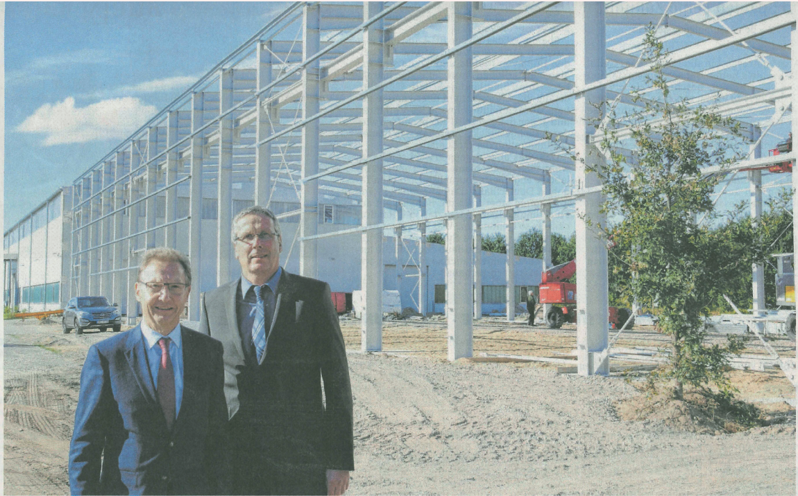
Friedrich-Wilhelm Wentrot (links) und Produktionsleiter Detlef Thoden vor dem Rohbau der 4400 Quadratmeter großen neuen Halle. FOTO: KLAUS GÖCKERITZ
