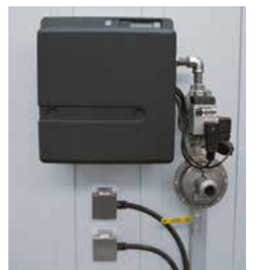
用于至 NB 600 的标准型的紧凑型燃烧器
