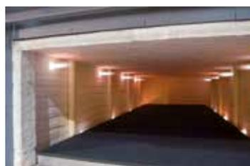
Vano interno del forno con otto bruciatori ad alta velocità
