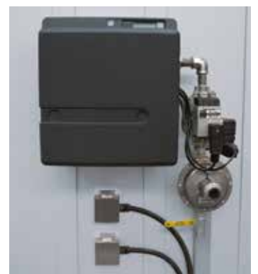
Компактная горелка для стандартных моделей до NB 600
