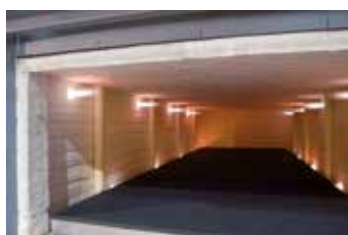
Внутреннее пространство печи с восемью горелками сверхбыстрого сжигания
