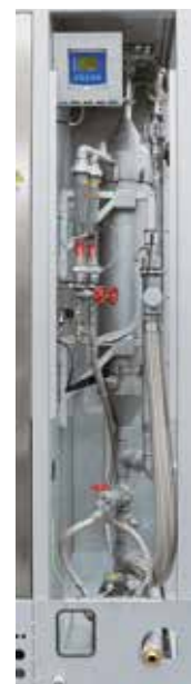
Система очистки технологических газов методом промывки
