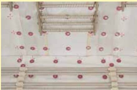
纤维顶面（和侧面）采用织布覆盖，以减少纤维粉尘
