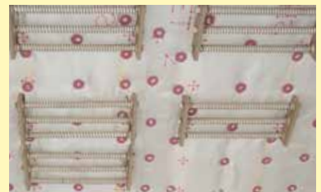
Cubierta del aislamiento de fibra con una capa de tejido para reducir la carga de polvo en el horno
