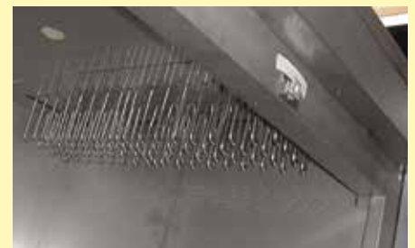
Registros calefactores en versión de calentamiento eléctrico
