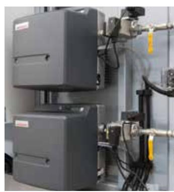
电炉加热装置和热力式后燃烧器的气体燃烧器
