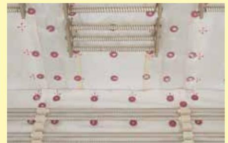
Gewebetuchabdeckung der Faserdecke (und Seiten) zur Reduzierung von Faserstäuben
