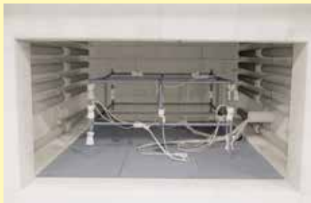
アニール炉での測定設置
