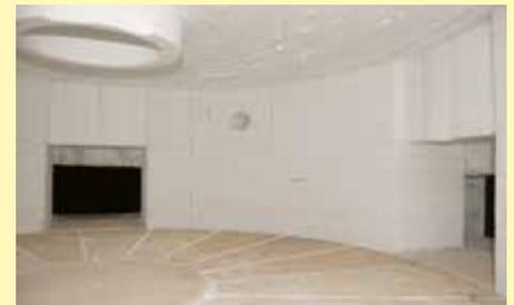
Drehtisch mit Auflageplatten aus feuerfestem Beton zum Schutz der Isolierung
