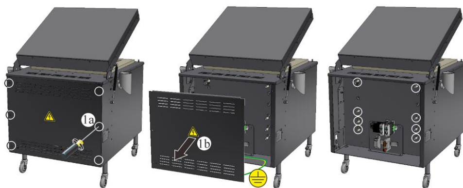
Fig. 59: Demontera kopplingsanläggningens skyddsbeklädnad på ugnens baksida (bilden är en liknande bild)
