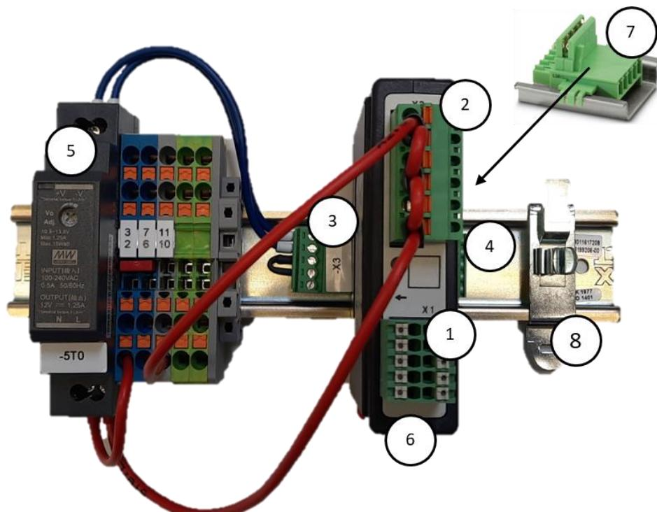
图13：电源装置和控制器模块（与插图相似）
