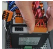
Afb. 11: inbouw van de regelmodule (afbeelding vergelijkbaar)
