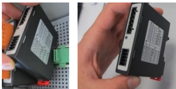
Démontage des modules régulateurs – Partie 2 (figure similaire)
