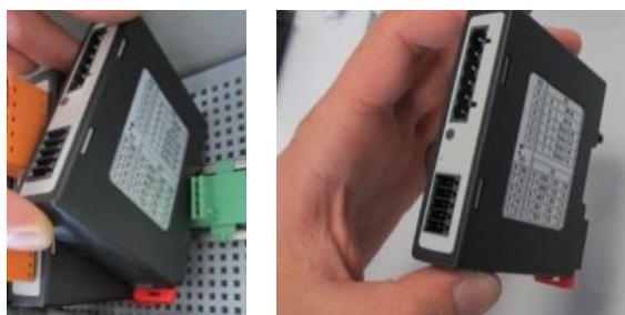
Demontaža regulacijskih modula – dio 2 (slično kao na slici)
