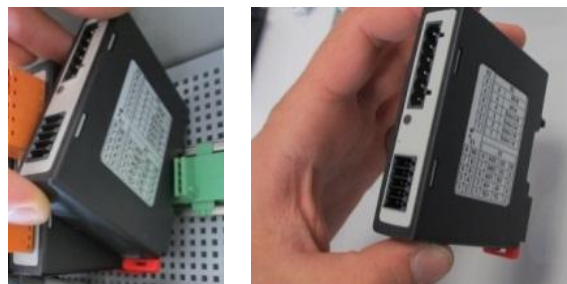
Démontage des modules régulateurs – Partie 2 (figure similaire)
