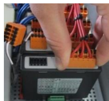
13 pav.: Reguliavimo modulių montavimas (panašus pav.)
