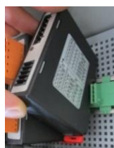
Slika 13: Vgradnja modulov regulatorja (podobno kot na sliki)
